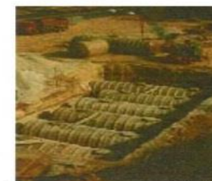
Tanques enterrados sem bacia de retenção
