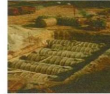
Tanques enterrados sem bacia de retenção
